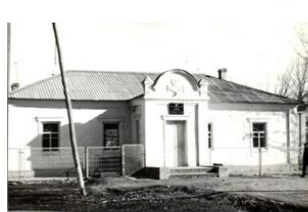
Здание детской поликлиники, затем «Сбербанка» (теперь здание Сбербанка) по улице Д.Ковалева
